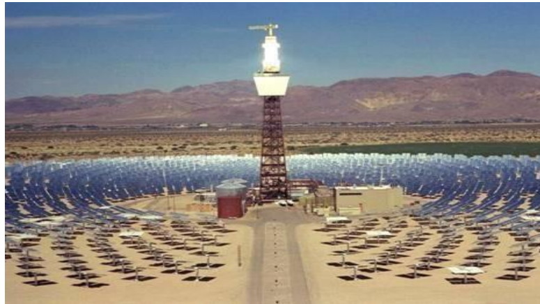
Figure 2.9. Energie solaire sur tour
