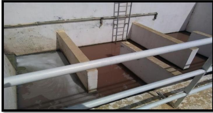
**Photo 11:** Photo de bassin chloration de la lagune de aérée de Moulay Slissen (Source : ONA, 2017).
