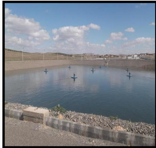
**Photo 05 (b)**: Photo bassin d'aération de la lagune aérée de Ras El Ma (source : ONA, 2016)
