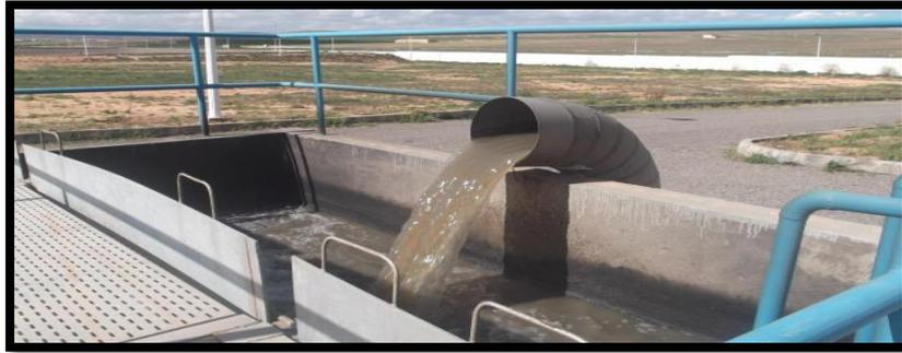
**Photo 04** : Photo Ouvrage de prétraitement de lagune aérée de Ras El Ma (source : ONA, 2016).
