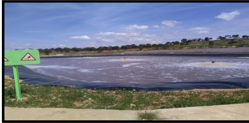
**Photo 09 :** Bassin d'aération avec 3 aérateurs de la lagune de aérée de
