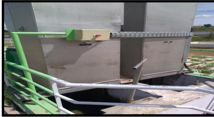
**Photo 06 :** Photo de Dégrilleur de la lagune de aérée de
