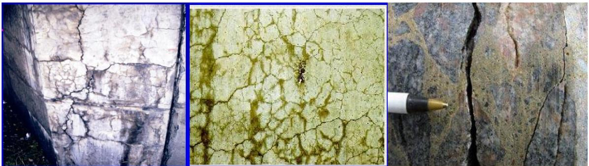
**Figure 3.9.** Fissuration en réseau et faïençagedû à l'alcali-réaction (Guide LCPC). [5]
