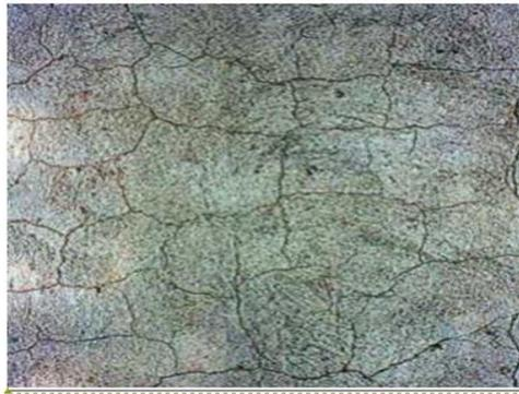
**Figure I.8.** Réseaux de fissures de surface.
