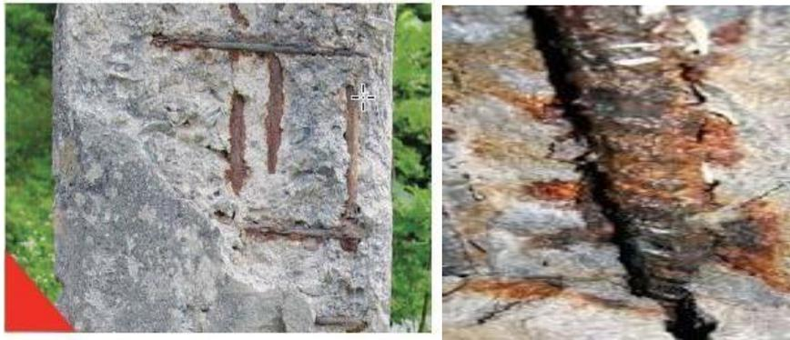
**Figure 4.3.** Dégât de corrosion d'une armature : érosion par corrosion régulière de la barre d'armature sous l'effet de la carbonatation.
