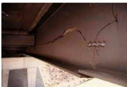
**Figure 4.52.** Fissuration d'un pont.
