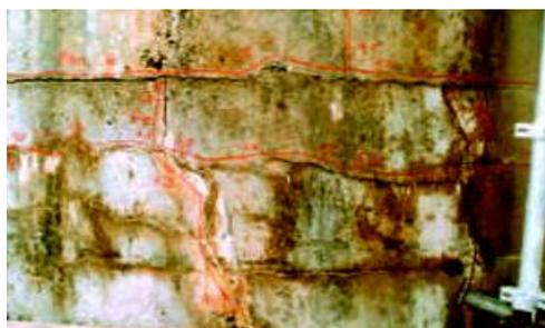
**Figure 3.32.** Pile de pont affectée par une réaction de gonflement interne due à la formation d'ettringite différée.
