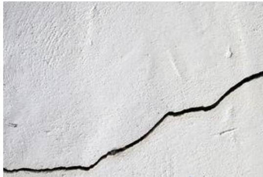
**Figure I.7** : la fissuration du béton. [30]
