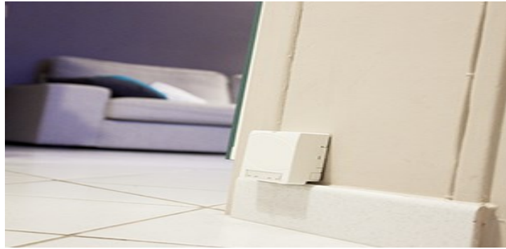
Figure V.16. Prise terminale optique FTTH.
