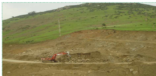
Photo:4.3.1. Destruction d'une superficie de ligneuse
