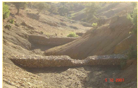
Photo:3.1.5.1.3. L'effet de la correction torrentielle
