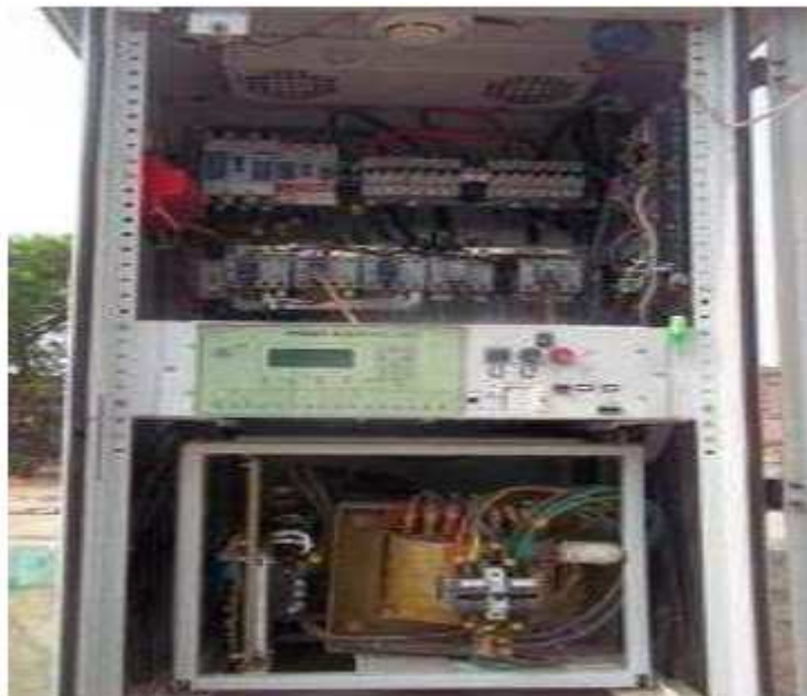
Figure II.3. Unité de distribution d'énergie (PDU) typique [1].
