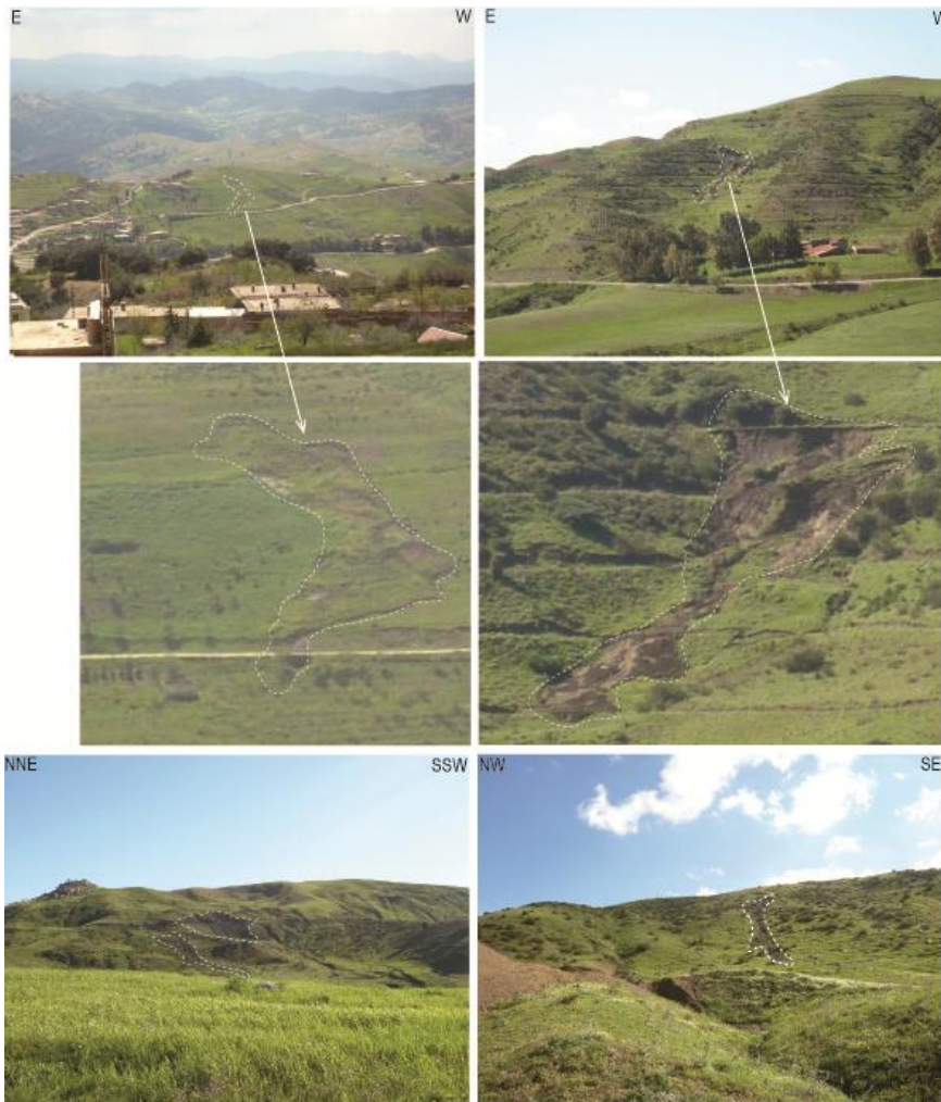
Figure 8: photos montrant des glissements translationnels, a et b : glissements translationnels complexes, c et d : glissements translationnels superficiels.
