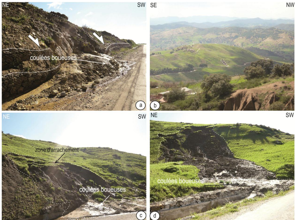
Figure 9: Glissements coulées (coulées boueuses), a, coulées boueuses avec circulation des fluides en aval de la zone d'arrachement, b : glissement coulée affectant la route reliant Douar Mkhatria à BBN, c : sur la même une coulée de boue montrant une forte concentration de fluides et d : un glissement rotationnel évolué en coulée boueuse en aval avec toujours une forte circulation des eaux.
