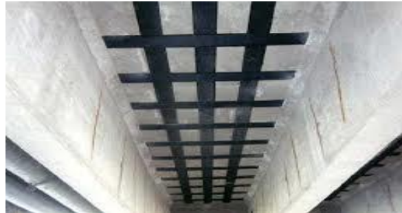
Figure 1.25. Renforcement des poutres en béton armé à l'aide de matériaux.
