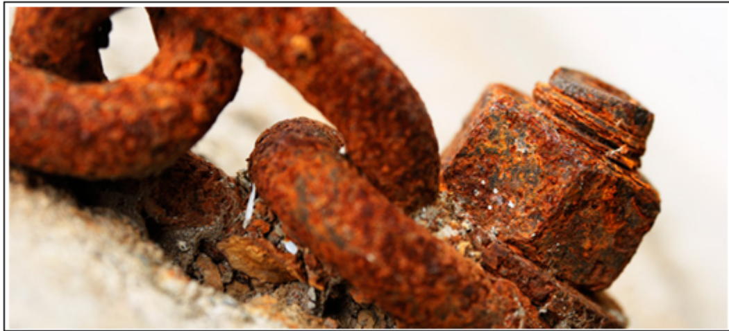
Figure 1.6: Corrosion généralisée ou uniforme [2].
