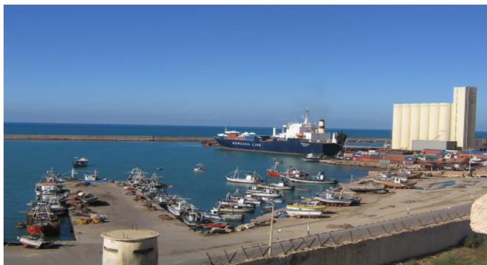
Figure 3 : Port de Mostaganem (silos de l'OAIC) Source : www.skyscrapercity.com/showthread.php?p=50399991
