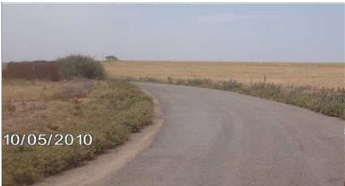
Photo N° 5 : Réalisation chemin rural reliant Ain Mansour-Ouled Bali à CW 35.
