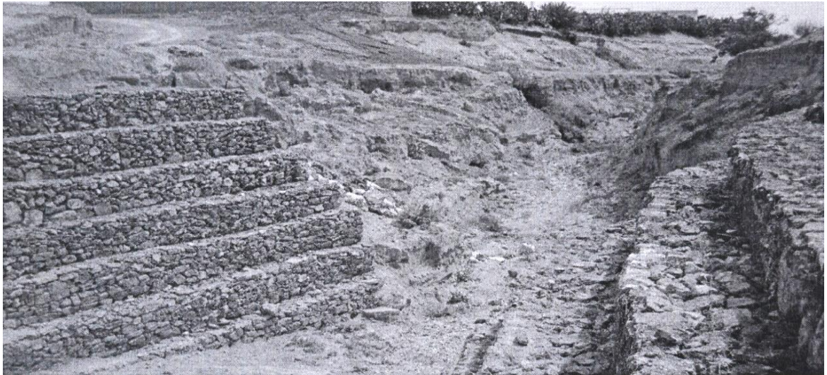
Photo 7 : Action réalisée de correction torrentielle.
