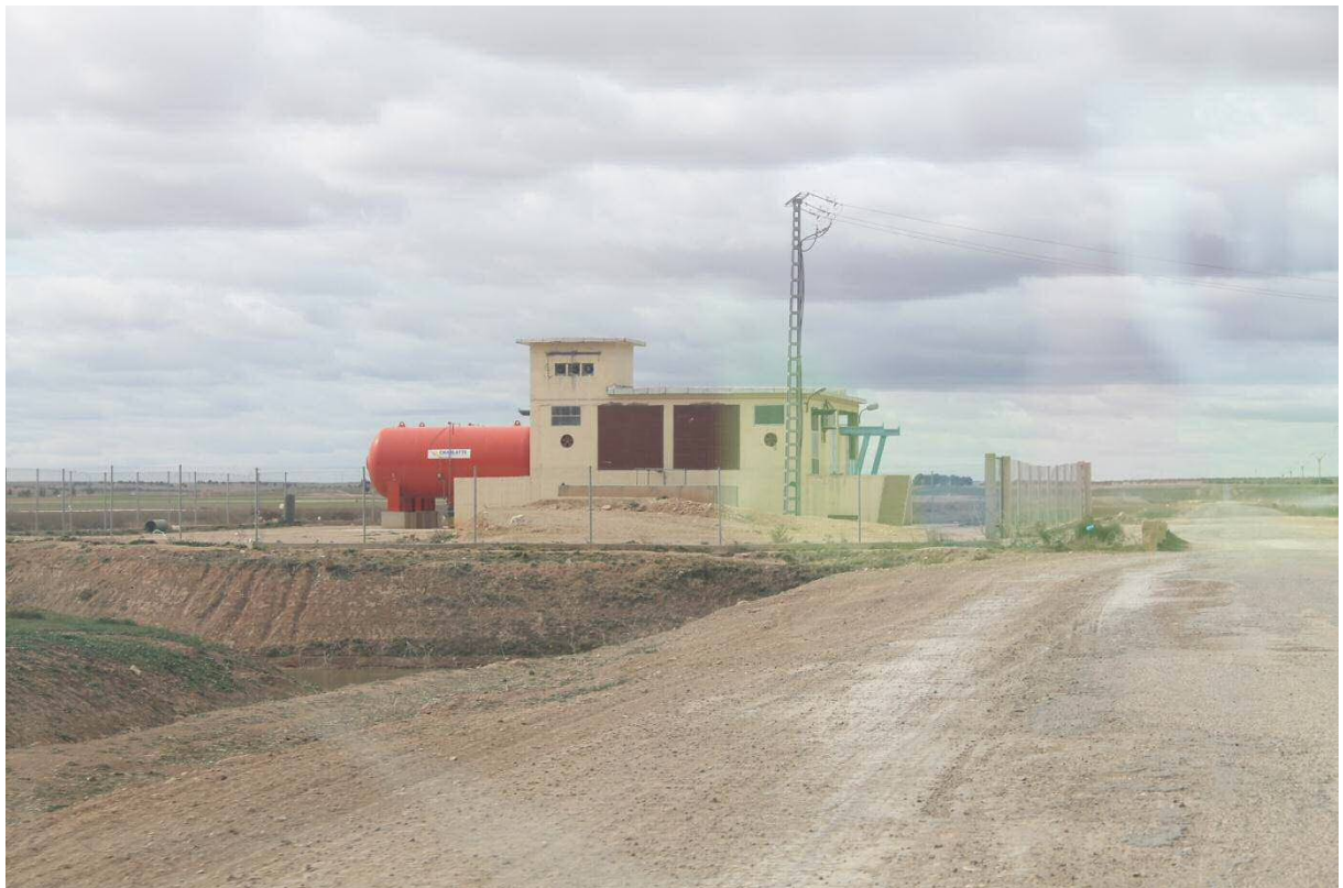
Photo n°08 : Station de pompage destinée à l'irrigation du périmètre de Zraguet (Boukhari.Y, Zahafi.B, Anteur.D,2016)
