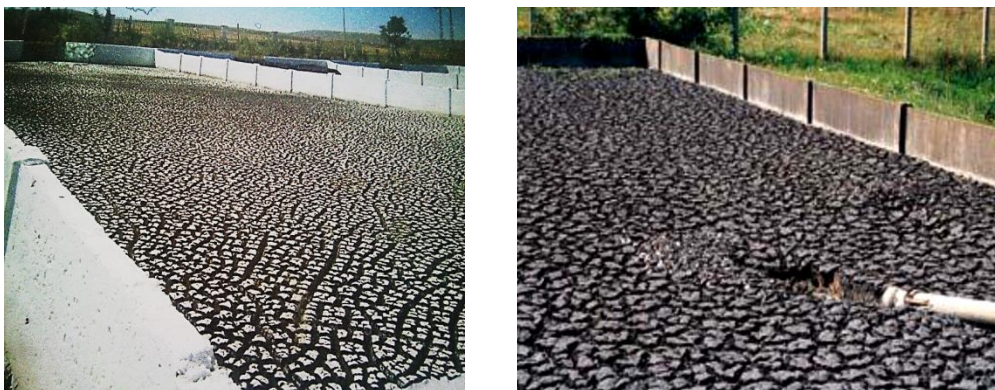
Figure II.3 : Lit de séchage des boues résiduaires.
