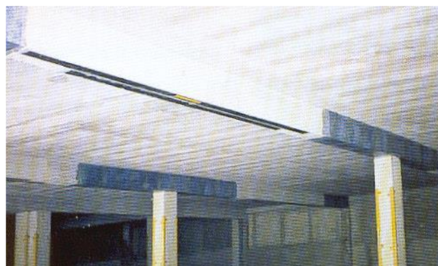
Figure (1) : Renforcement des poutres en béton armé.
