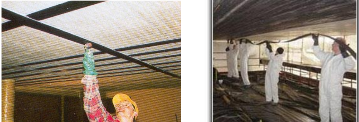
Figure (2) : Renforcement des planchers en béton armé.
