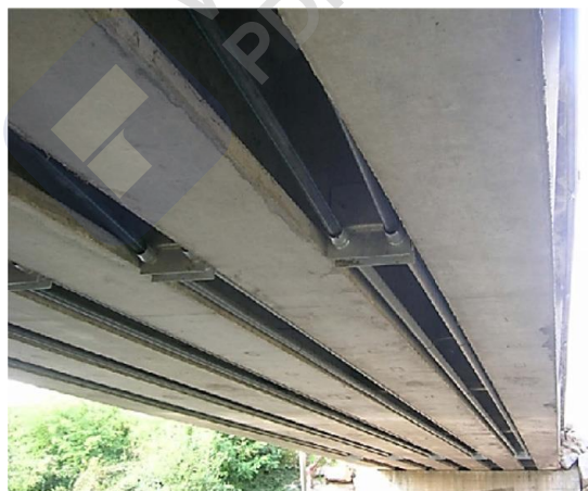
Figure (I.12) : Pont renforcé en situation réelle (Technique EPT) (Muhammad Aslam [1])
