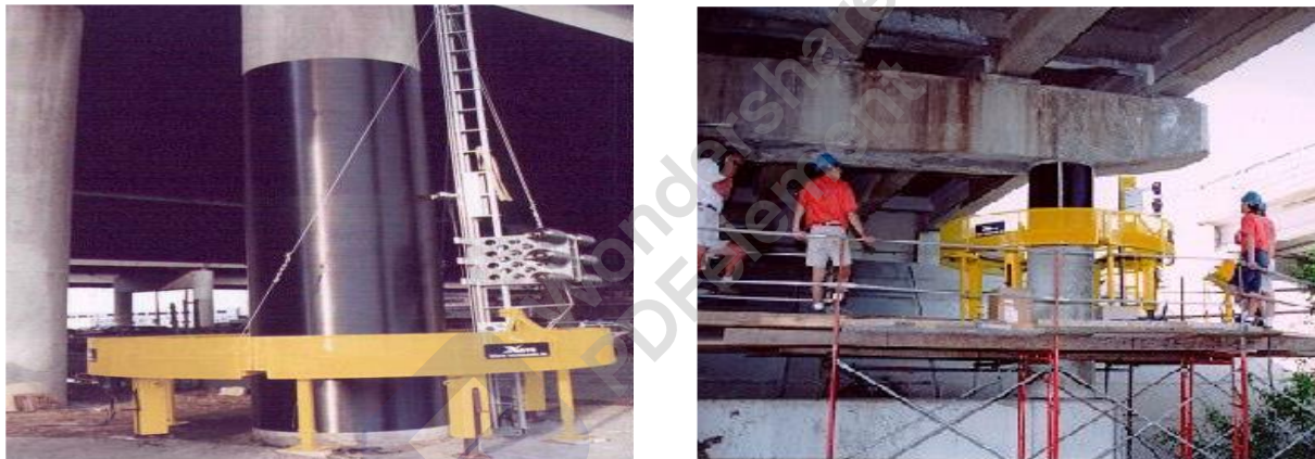
Figure (3) : Renforcement des poteaux en béton armé.
