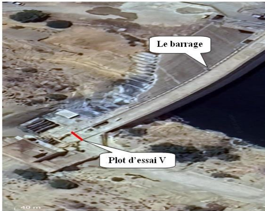
Figure V-68: Emplacement du plot d'essai V dans la rive gauche.
