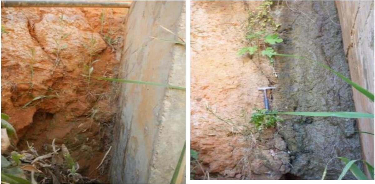
Contact barrage roche sec à la cote 193 m. Contact barrage roche ruisselant à la cote 207 m.
