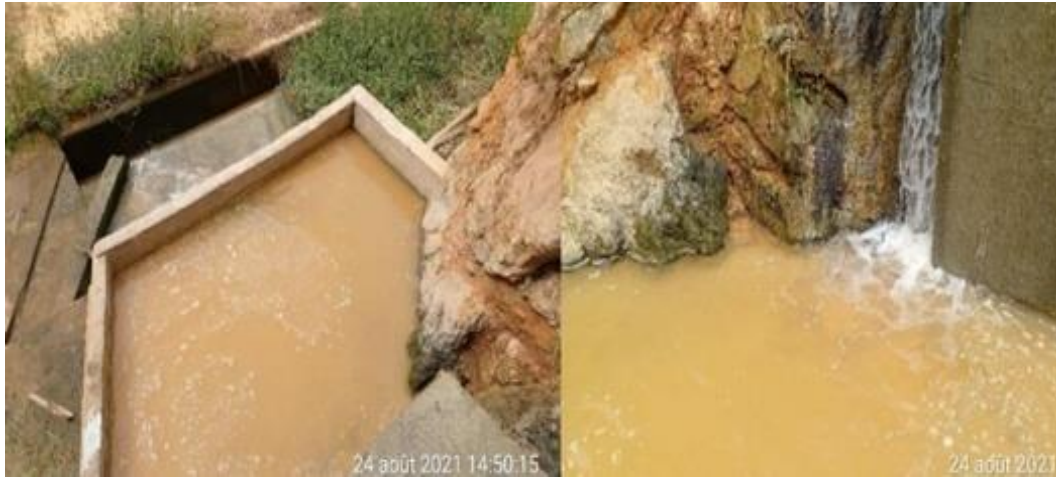
Figure V-38: Entrainement de fines lors de la perforation du forage P2 entre les cotes 206 et 201m.
