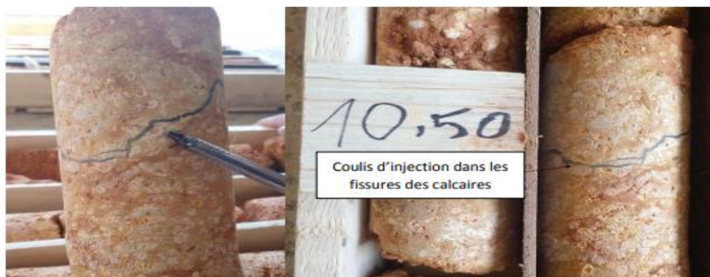
Figure V-44: Coulis d'injection dans les fissures des calcaires Tortoniens.
