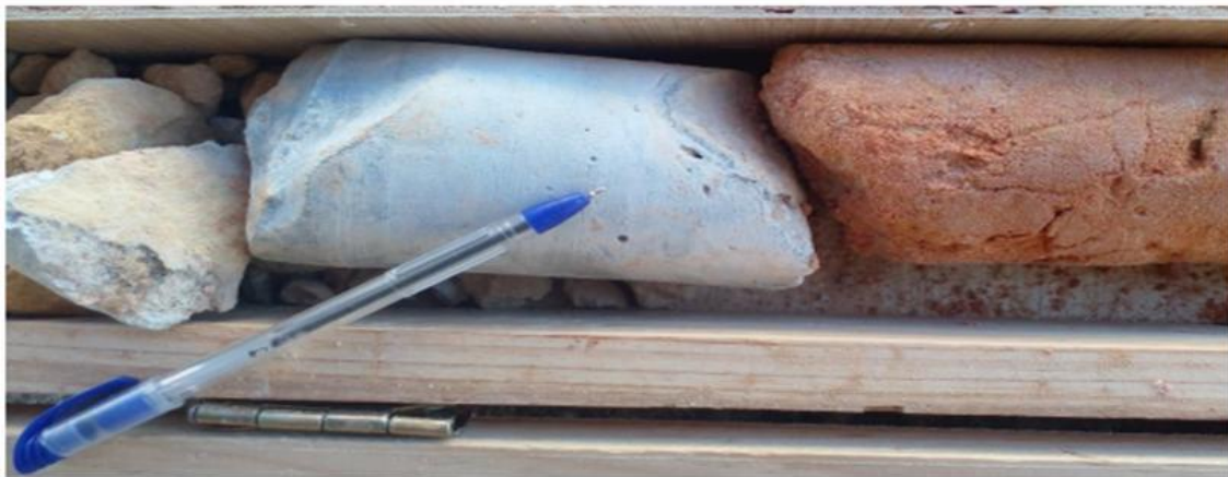
Figure V-46: Remplissage du vide par le coulis de ciment.
