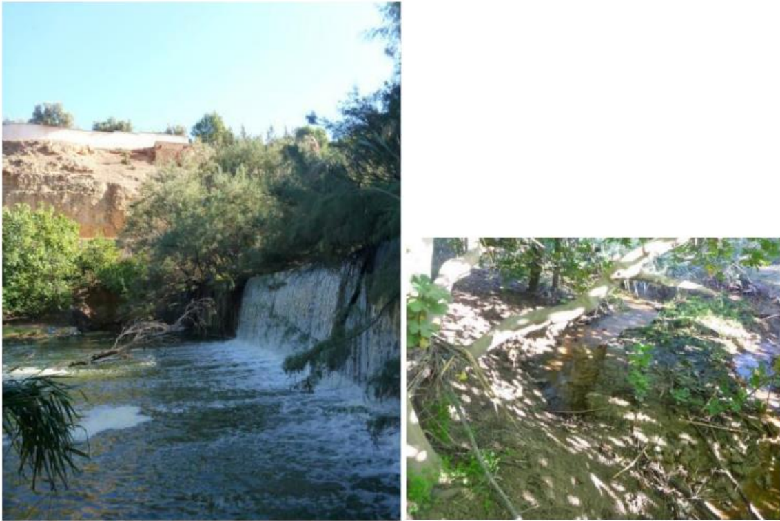
Figure IV-6: Seuil aval et sources rive gauche (ANBT, 2021)
