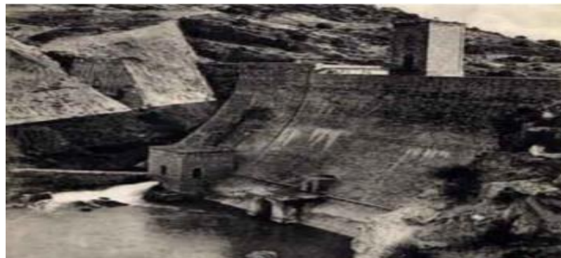
Figure III-2: Barrage de Cheurfas I après travaux : nouvel appui RD vers l'amont. (ABDOU et BEN HELLAL, 2019)
