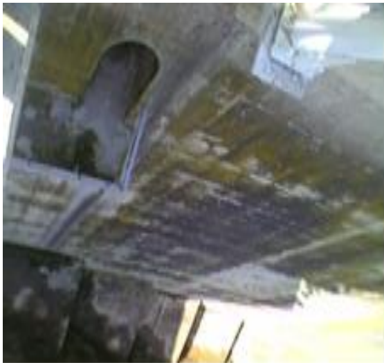
Entrée de la galerie de visite
