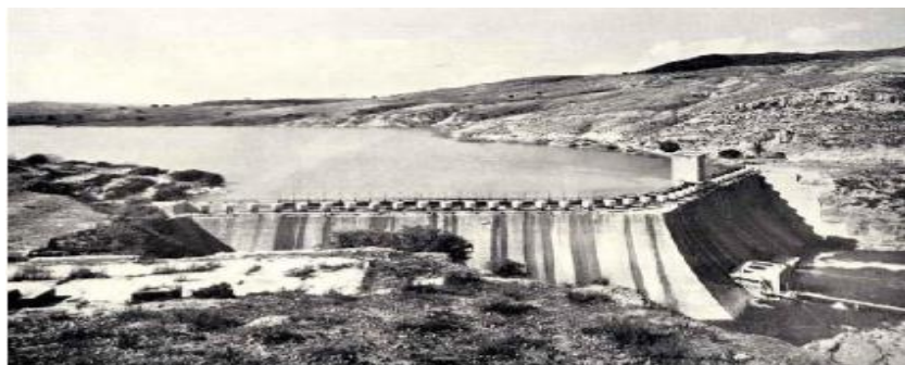
Figure III-3: Barrage de Cheurfas I après construction en 1892. (ABDOU et BEN HELLAL, 2019)
