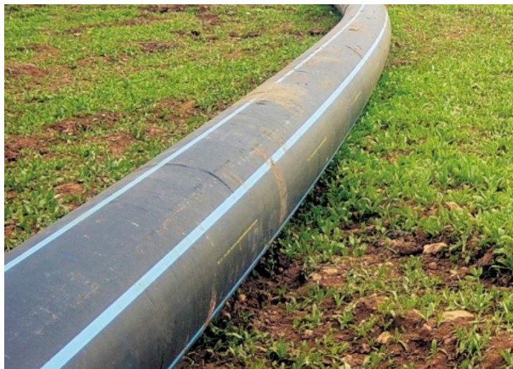
Figure I. 3. Conduite en PEHD [11]
