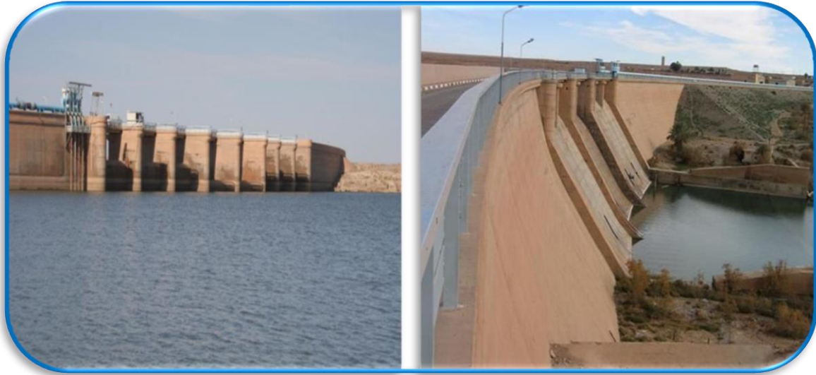
Figure III.1 : Le barrage de Djorf-Torba
