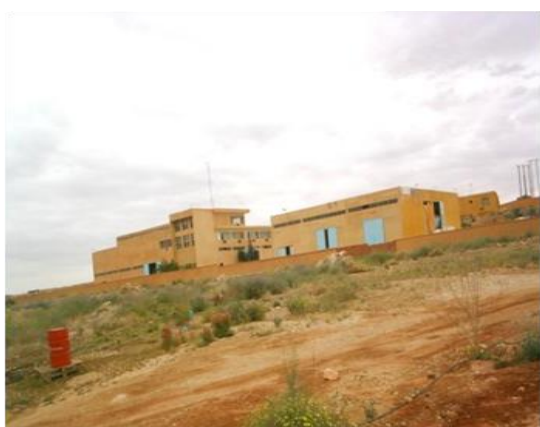
Station de traitement
